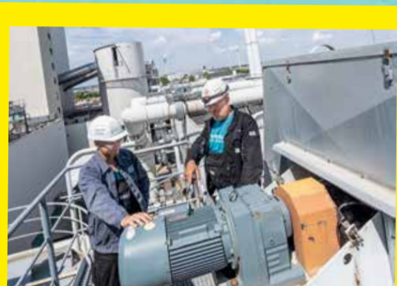
Arbeiten über den Dächern der Stadt – wer hat das schon?
