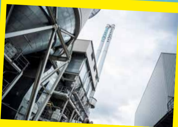
Im MHKW arbeiten 100 Allroundtalente, darunter Ingenieure, Anlagenmechaniker*Innen und Elektroniker*Innen ...
